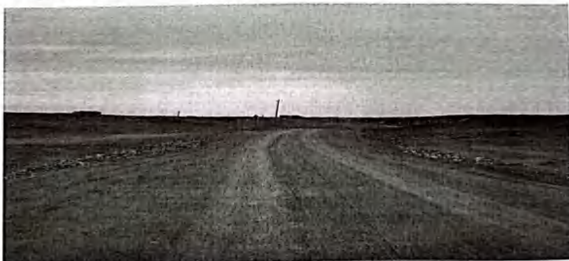
照片 1-15 矿区道路
